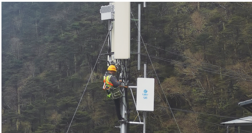
施工人员在山南市山林区域开展5G通信基站安装施工作业。西藏自治区通信管理局供图
