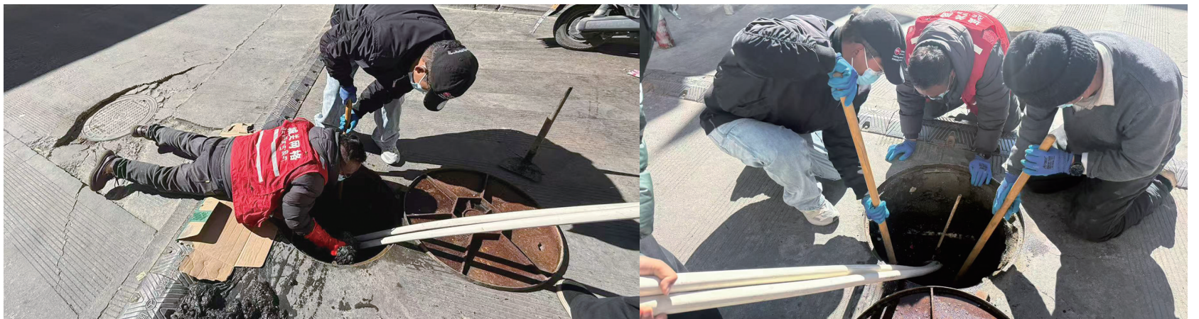
图为平措朗杰和同事正在疏通下水道。
