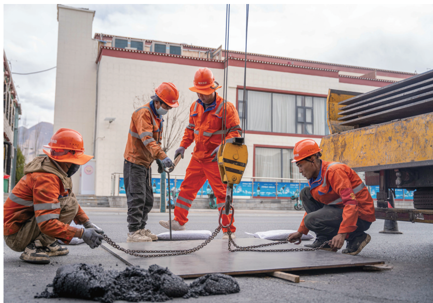
位于拉萨仙足岛滨河路污水井盖专项更换工作施工现场。
