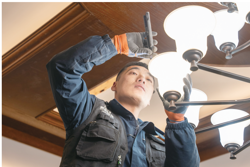
刘亮正在调试吊灯。
