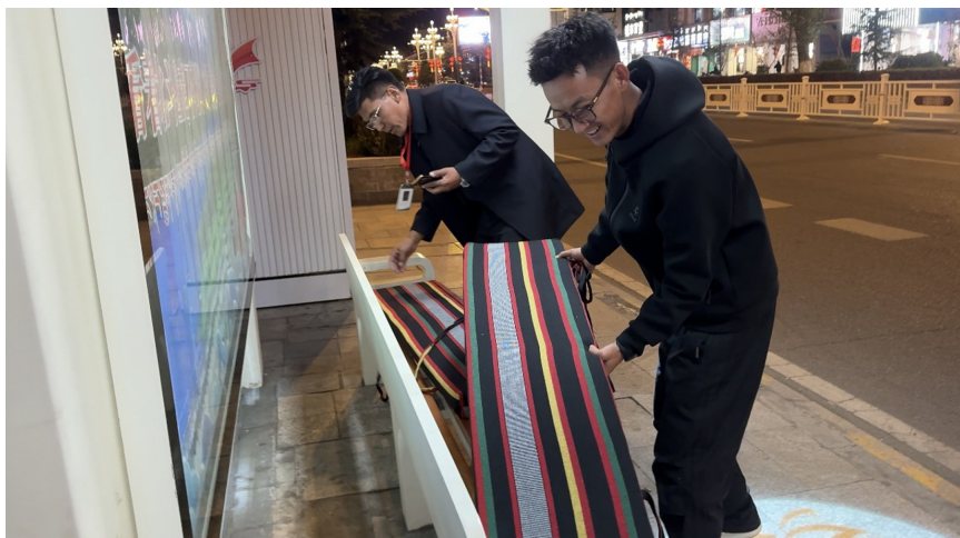
安装暖垫。图片来源:网络账号“多管局来了”
