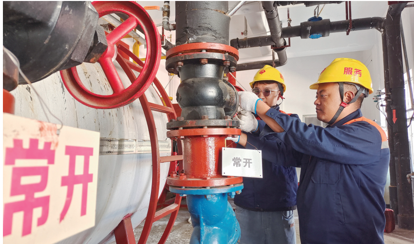
暖心公司组织所属单位组建专业技术骨干队伍,对各供暖维运单位所属供暖设备开展专项检修工作。 图由暖心公司提供
