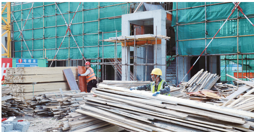
施工现场。图由果珍提供
