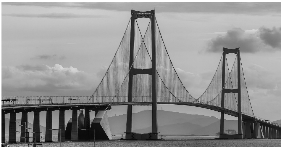
深中通道深中大桥。新华社记者 刘大伟 摄
