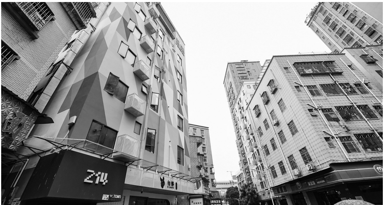
在深圳市龙华区元芬村拍摄的改造后的青年公寓外立面(左)。近年来,深圳持续推进城中村住房规模化品质化改造提升,打造了元芬村等新型宜居人文社区。 新华社记者 毛思倩 摄
