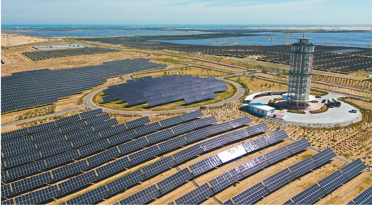
这是2025年7月30日拍摄的内蒙古鄂尔多斯市达拉特旗光伏基地(无人机照片)。
