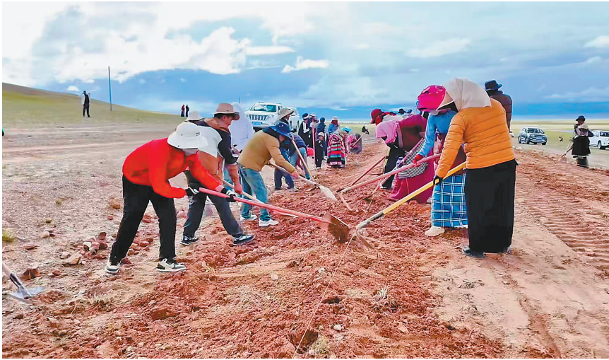
图为措勤县措勤镇门东社区转场道路施工现场。 本报记者 王莉 洛桑旦增 摄
