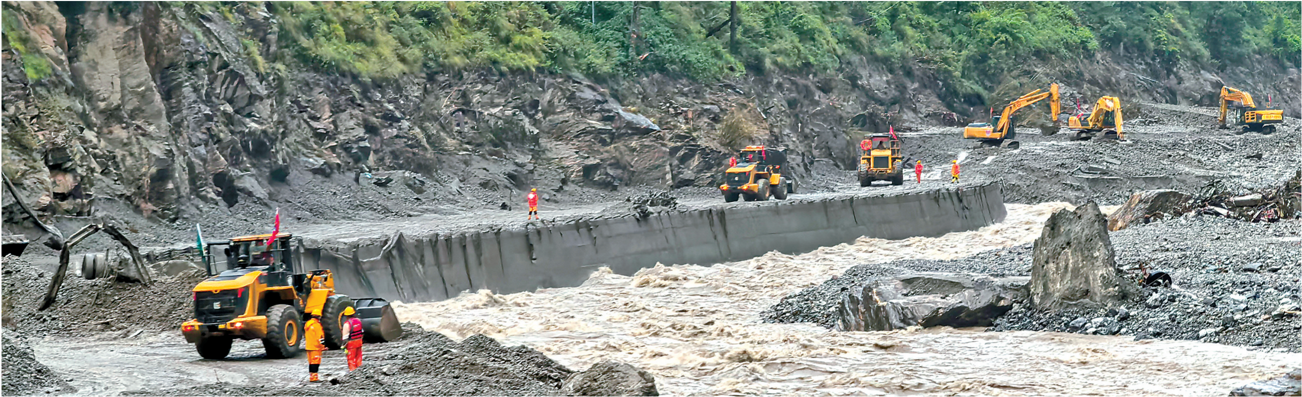
▲8月27日,西藏交通运输抢险保通人员在G216线受损路段实施路面清淤作业。西藏自治区公路事业发展和应急保障中心供图
