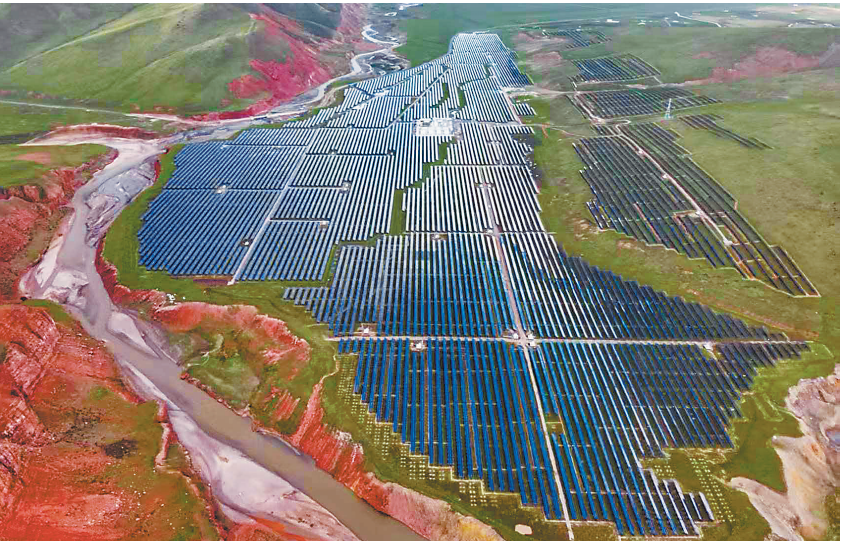
图为航拍镜头下的比如县伯托150MW光储电站。 本报记者 曲珍 摄
