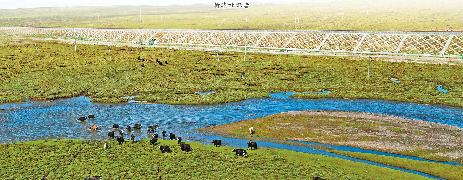
图为在西藏自治区那曲市色尼区境内的青藏铁路旁,牦牛通过涵洞后渡河(2026年6月18日摄,无人机照片)。
