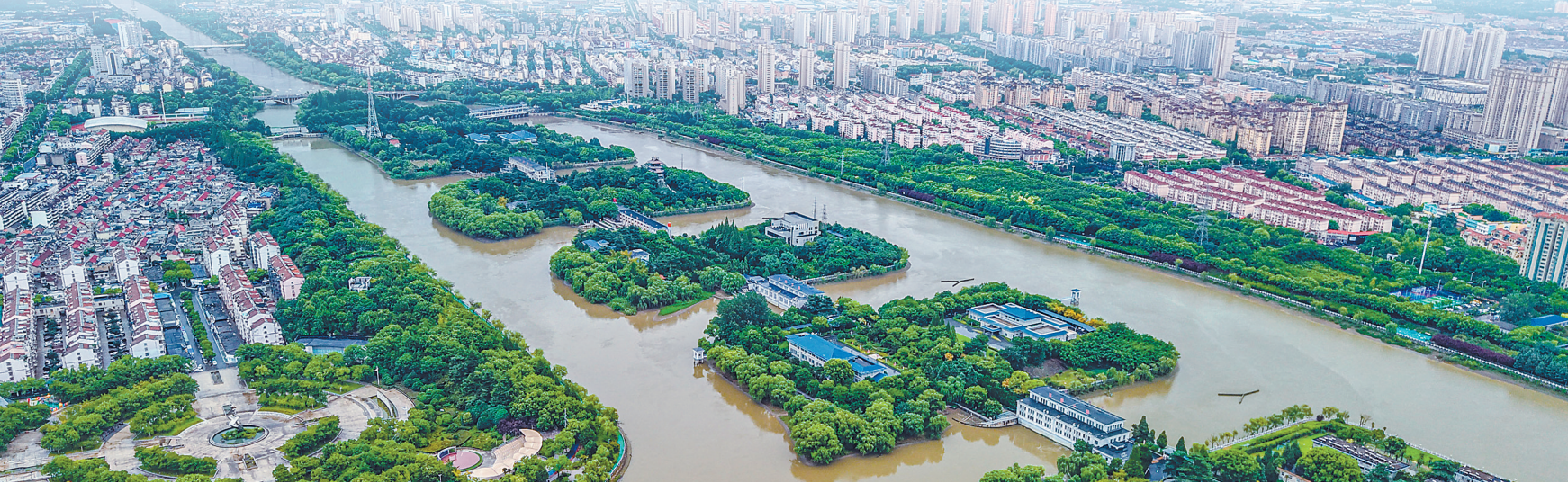
图为8月11日拍摄的位于江苏省扬州市江都区的南水北调东线源头江都水利枢纽（无人机照片）。
