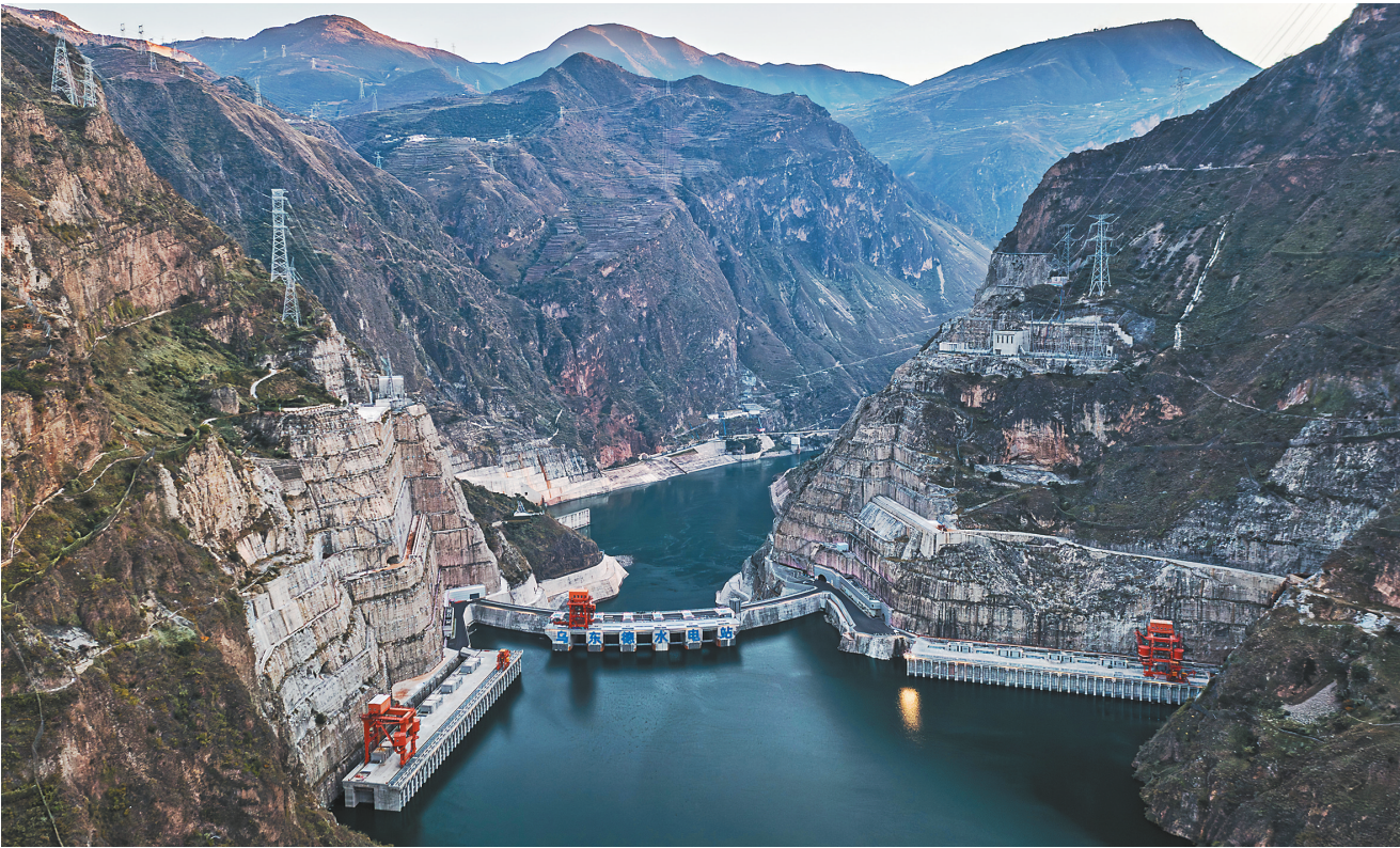
这是2025年12月18日拍摄的乌东德水电站(无人机照片)。
