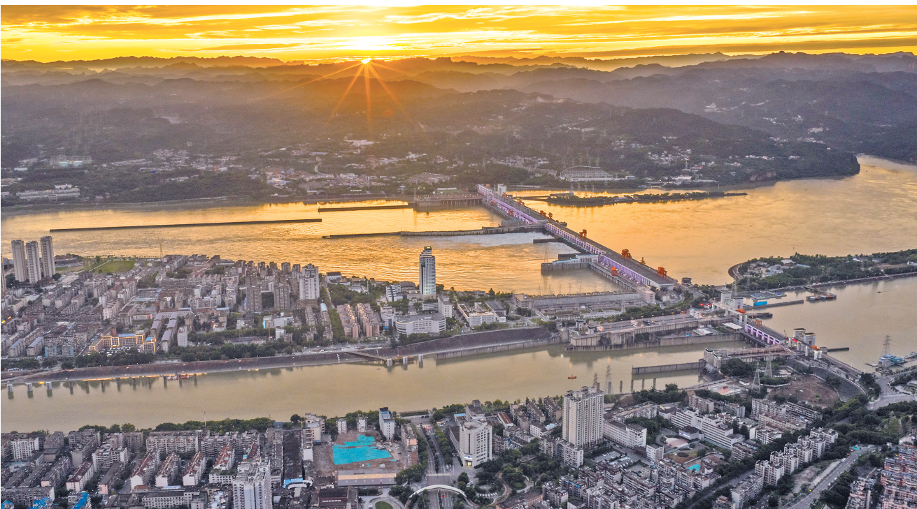
图为2026年6月8日,夕阳映照在三峡水运新通道工程葛洲坝航运扩能施工现场。当日,我国“十五五”期间开工建设的首个国家重大标志性工程——三峡水运新通道破土动工。
