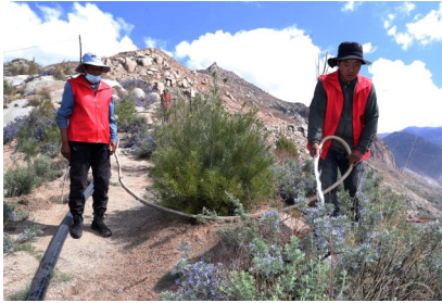
图为南北山绿化工程的工作人员正在给绿植浇水。
