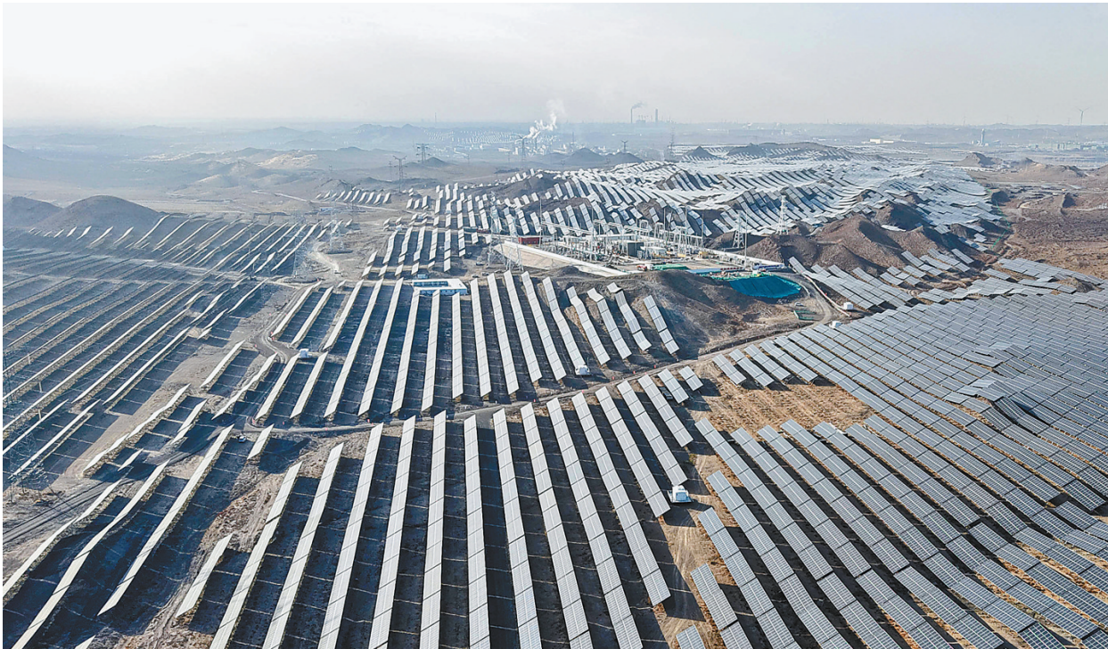
图为位于宁夏中卫市腾格里沙漠边缘的大唐中卫云基地数据中心绿电供应200万千瓦新能源项目(2026年2月10日摄,无人机照片)。
