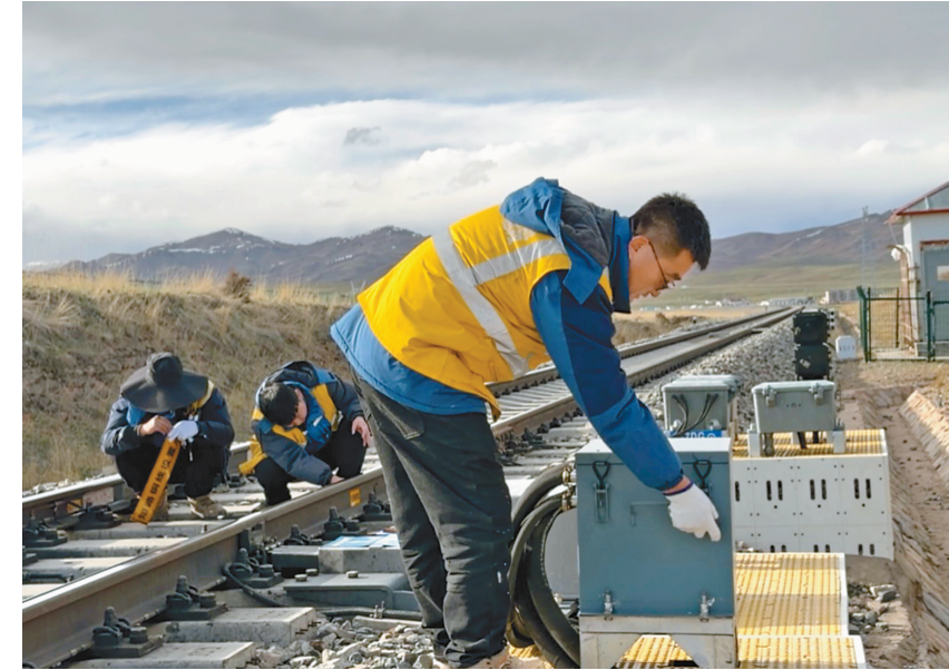
图为安多信号工区职工对安多站道岔进行日常养护和融雪装置通电试验。
