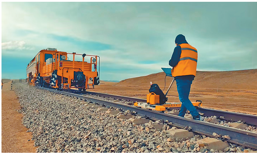
图为工作人员在使用国产0级轨道检查仪进行轨道测量。
