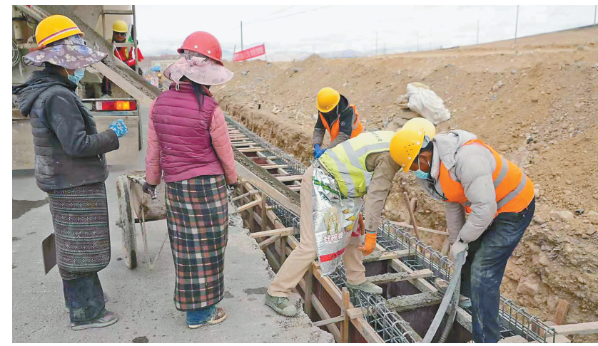
图为钢筋绑扎培训现场。
