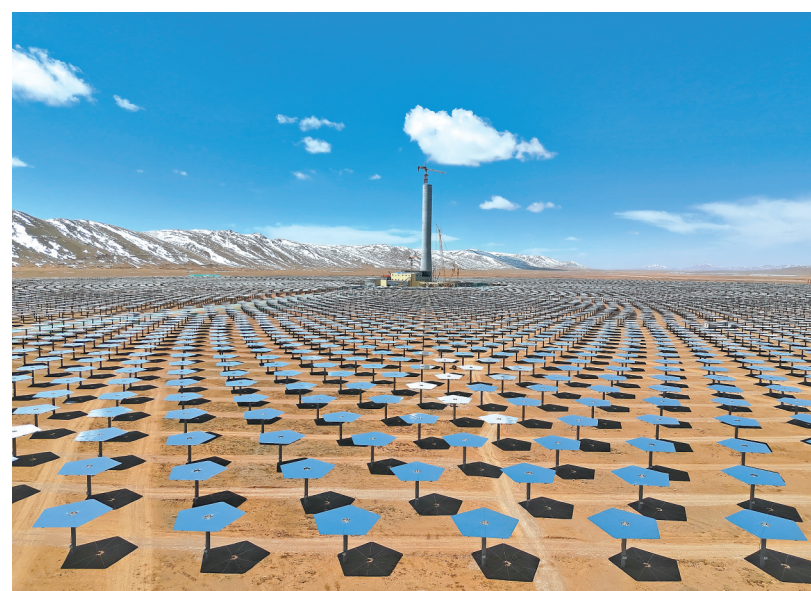
图为西藏开投土硕100MW塔式光热电站整齐排列的定日镜。
