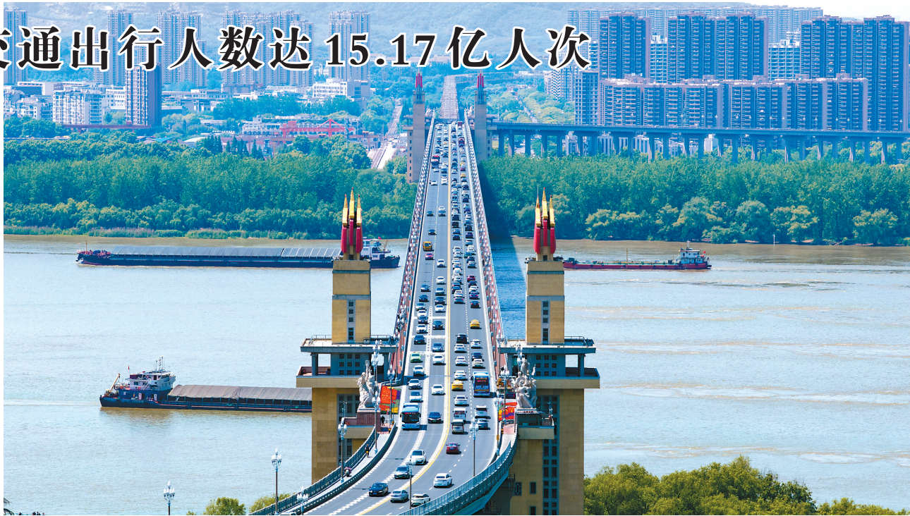
图为5月1日拍摄的南京长江大桥(无人机照片)。
