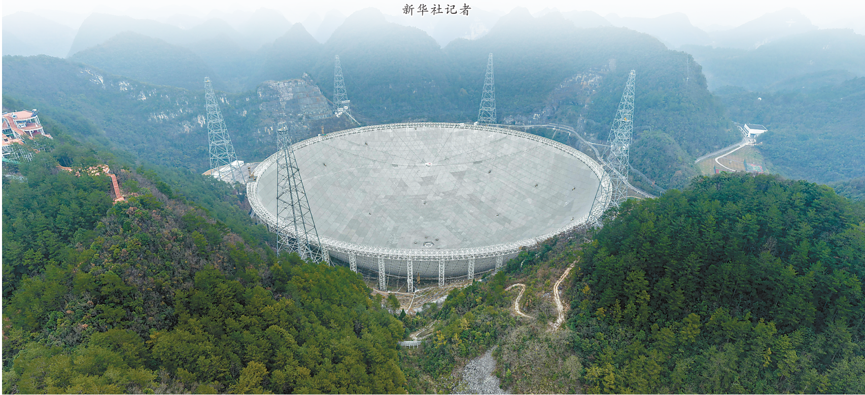
图为2026年1月16日拍摄的“中国天眼”(无人机照片,维护保养期间拍摄)。
