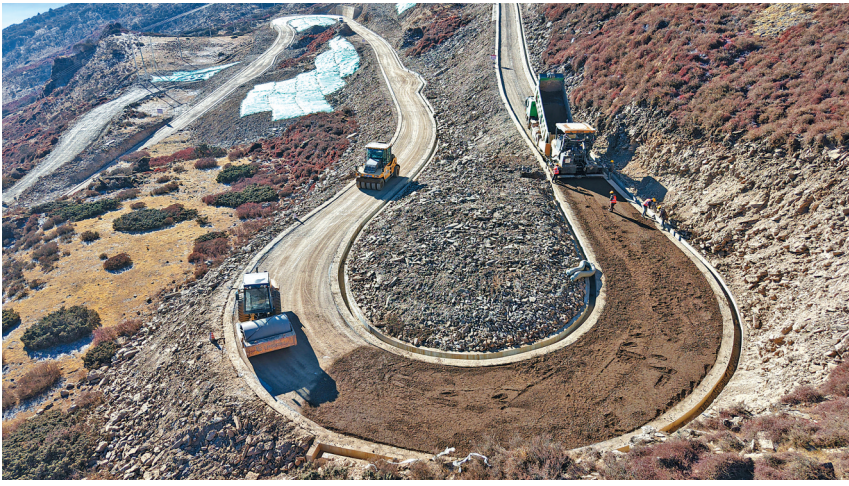
图为吉隆县国道216线岔口至萨勒乡公路工程施工现场。
