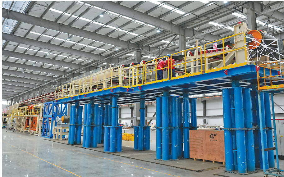
4月21日，由铁建重工自主研发的大型隧道连续皮带机在长沙完成安装调试，即将发运西班牙进行交付。这是国产连续皮带机首次进入西班牙市场。
