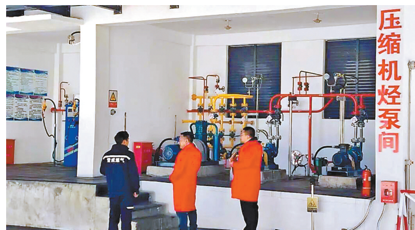
▲林周县市场监管局深入液化气充装站实行全方位无死角排查。
