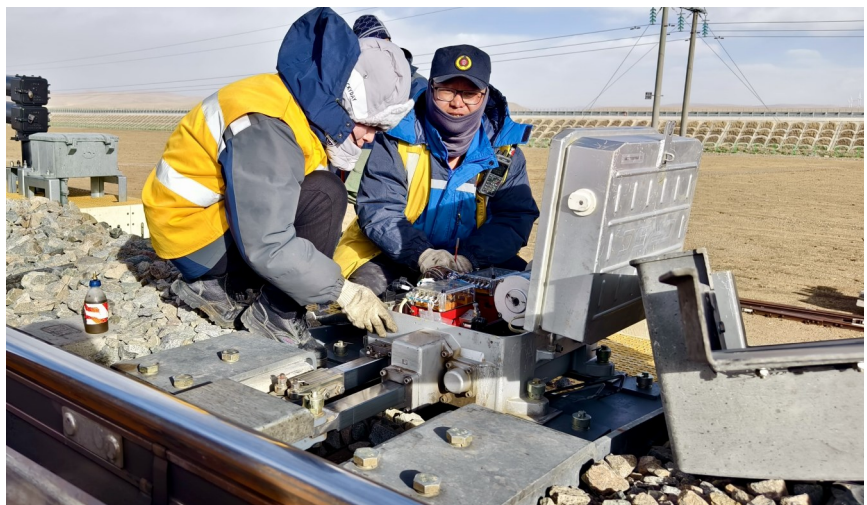
▲中国铁路青藏集团有限公司工作人员在进行检修作业。
