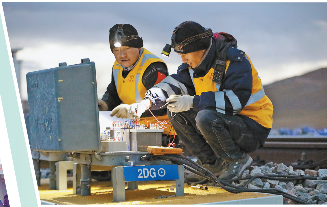
图为近日,中国铁路青藏集团有限公司拉萨基础设施段那曲信号车间扎加藏布信号工区职工在对信号机进行电气特性测试及数据记录。 本报记者 旦增兰泽 本报通讯员 拉巴次仁 摄
