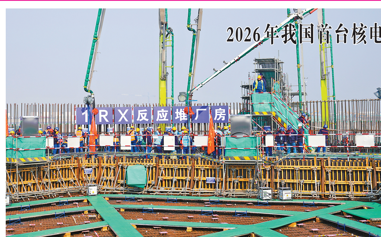
图为1月16日,工人在1号机组核岛浇筑混凝土。
