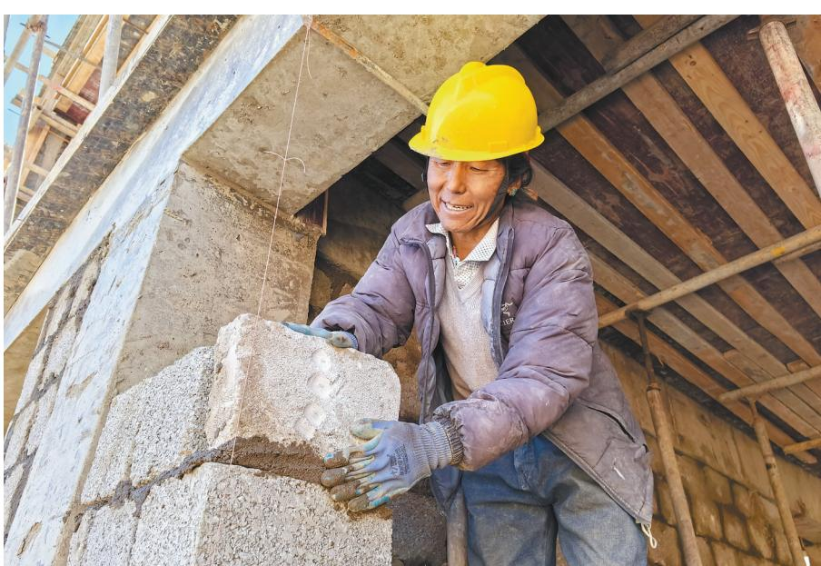
图为米玛自然村最后一户重建房屋进入二次结构施工阶段，施工人员在砌筑墙体。
