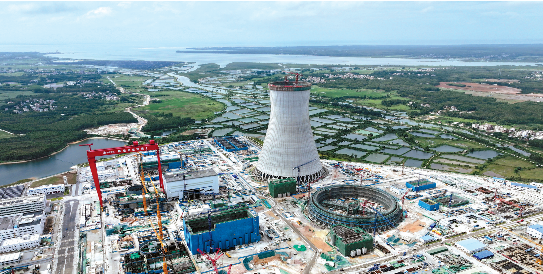
9月17日,中国首个采用海水二次循环冷却技术的广东廉江核电项目,顺利完成超大型高位集水海水冷却塔主体结构施工,即将全面进入设备安装与系统调试阶段。图为9月17日拍摄的国家电投广东廉江核电项目施工现场(无人机照片)。
