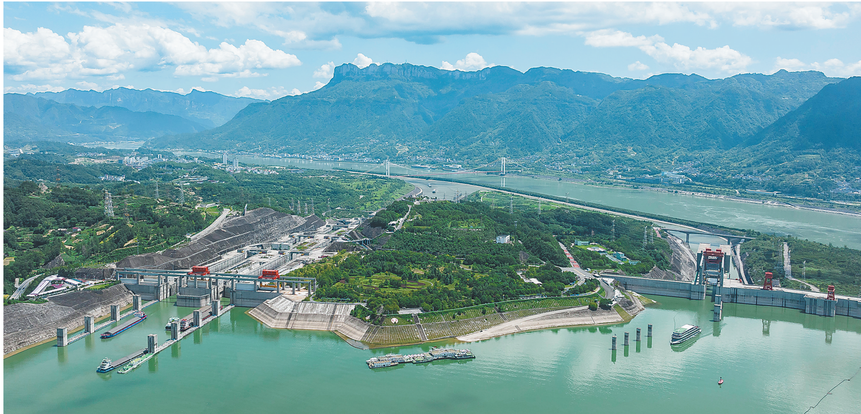
8月15日13时许，随着西陵峡“和谐号”游轮缓缓进入承船厢靠泊并顺利通过三峡大坝，世界最大“船舶电梯”——三峡升船机累计客运量突破200万人次。图为8月16日，在湖北省宜昌市，船舶有序通过三峡双线五级船闸和三峡升船机（无人机照片）。
