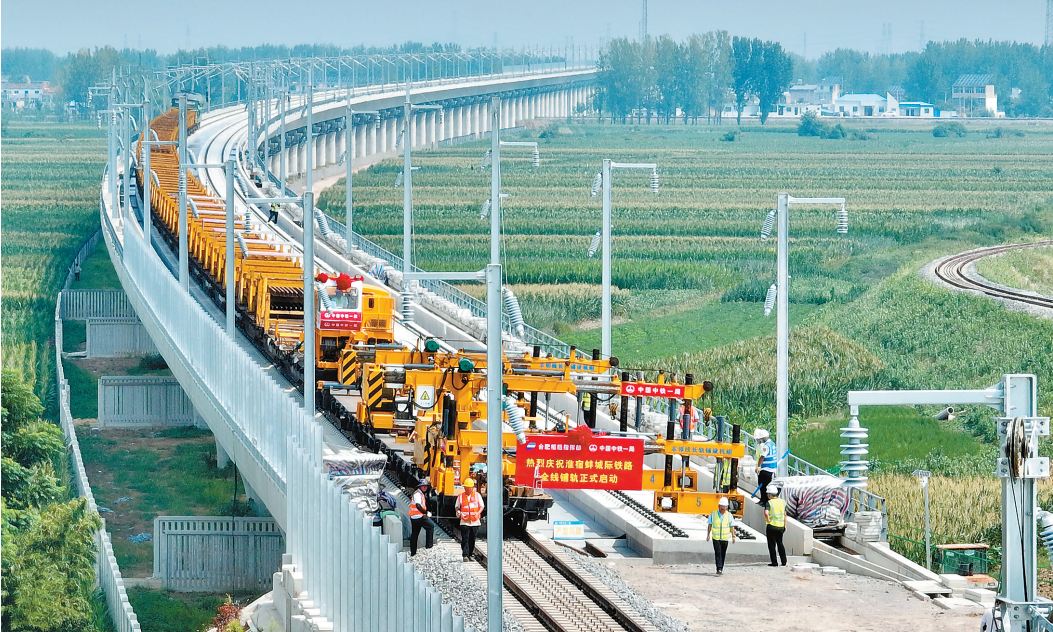
8月6日,在淮宿蚌城际铁路铺轨施工现场,中铁一局施工人员将首对500米长钢轨铺设在无砟轨道上,这标志着淮宿蚌城际铁路全线开始铺轨。
