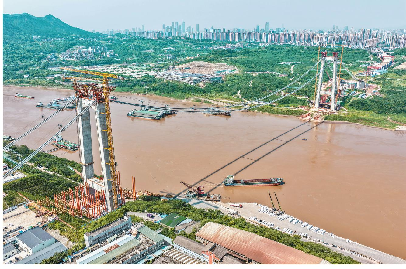
7月30日,由重庆城投集团投资、城投建设公司组织建设、中国铁建大桥局承建的黄桷沱长江大桥顺利完成主缆架设工作,标志着大桥建设即将进入钢桁梁吊装工序。黄桷沱长江大桥全长1260米,主跨765米,为单跨悬吊双塔三跨连续钢桁梁悬索桥,是国内最大跨径公轨两用悬索桥。黄桷沱长江大桥是渝长高速复线连接道工程的控制性节点工程,建成后将成为联系重庆主城区与长江南北两岸的重要交通干道。
