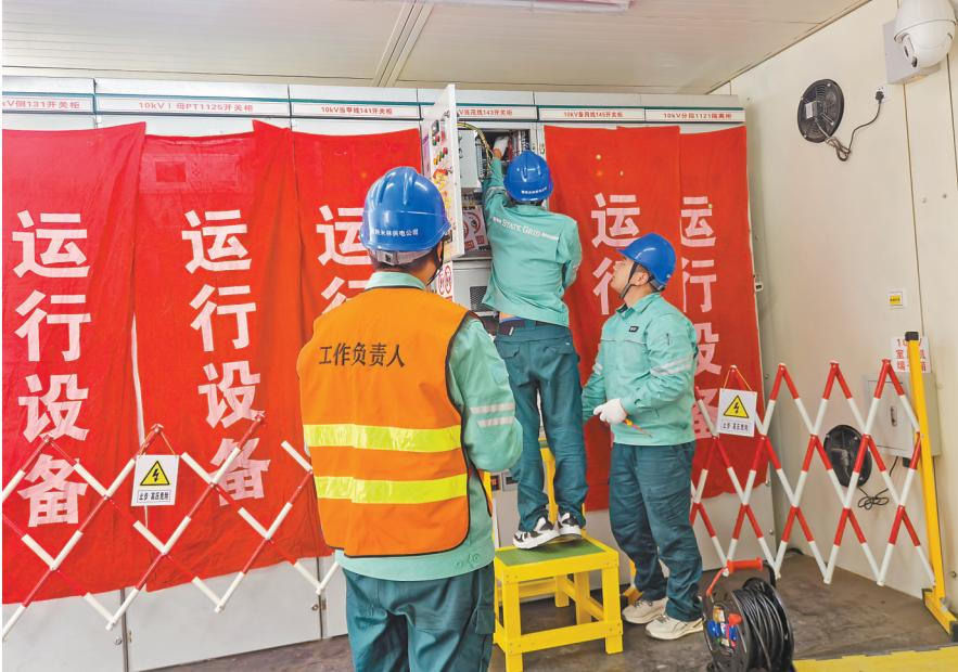
近日,国网米林市供电公司变电运检班依据精心编制的作业计划,首次自主开展保护测控装置定检作业,成功完成35kV当嘎变电站两条10kV馈线保测装置的全面检测,为电网安全稳定运行筑牢技术防线。
