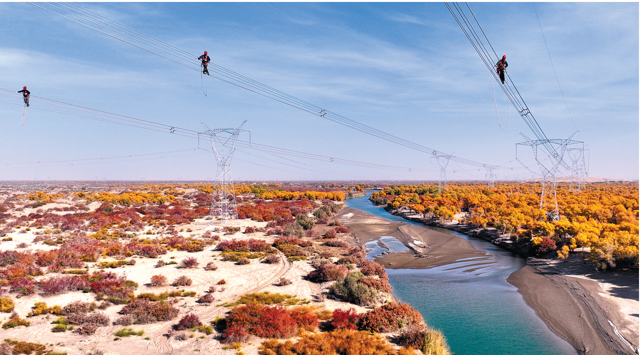
在巴州—铁干里克—若羌750千伏输电工程现场,作业人员开展走线消缺作业(2024年10月16日摄,无人机照片)。
