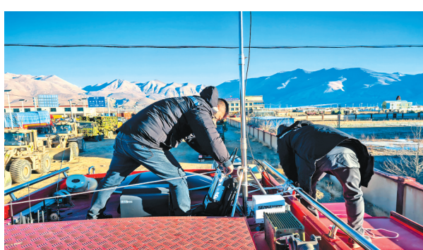
保障通讯 图为自治区应急管理厅工作人员在定日县搭建受灾区域应急窄带无线通信网。 毛娜 摄
