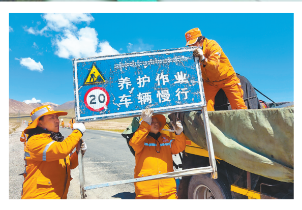
“天下第一道班”工人正在进行日常公路养护。
