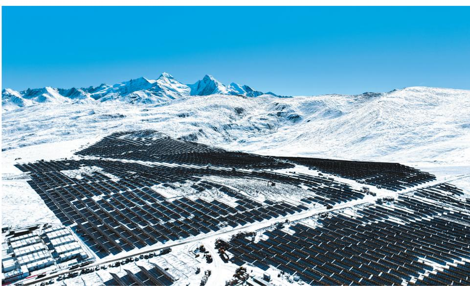
近日,全球海拔最高光伏电站——华电西藏才朋光储二期项目成功并网发电,17万块整齐排列的光伏板在海拔5000多米的山脊上。据悉,该项目地处山南市乃东区,海拔介于5046米至5228米之间,总装机10万千瓦,投产后预计年发电量1.55亿千瓦时,可满足约5万户家庭的年用电需求。
