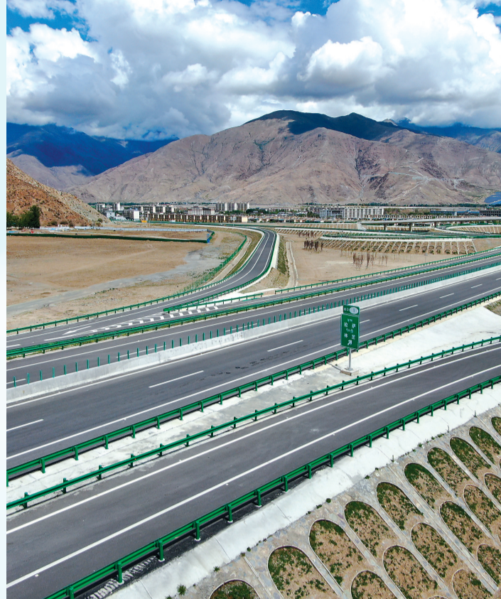
图为西藏S5线与林高等级公路的交叉路口(2024年6月26日摄)。
