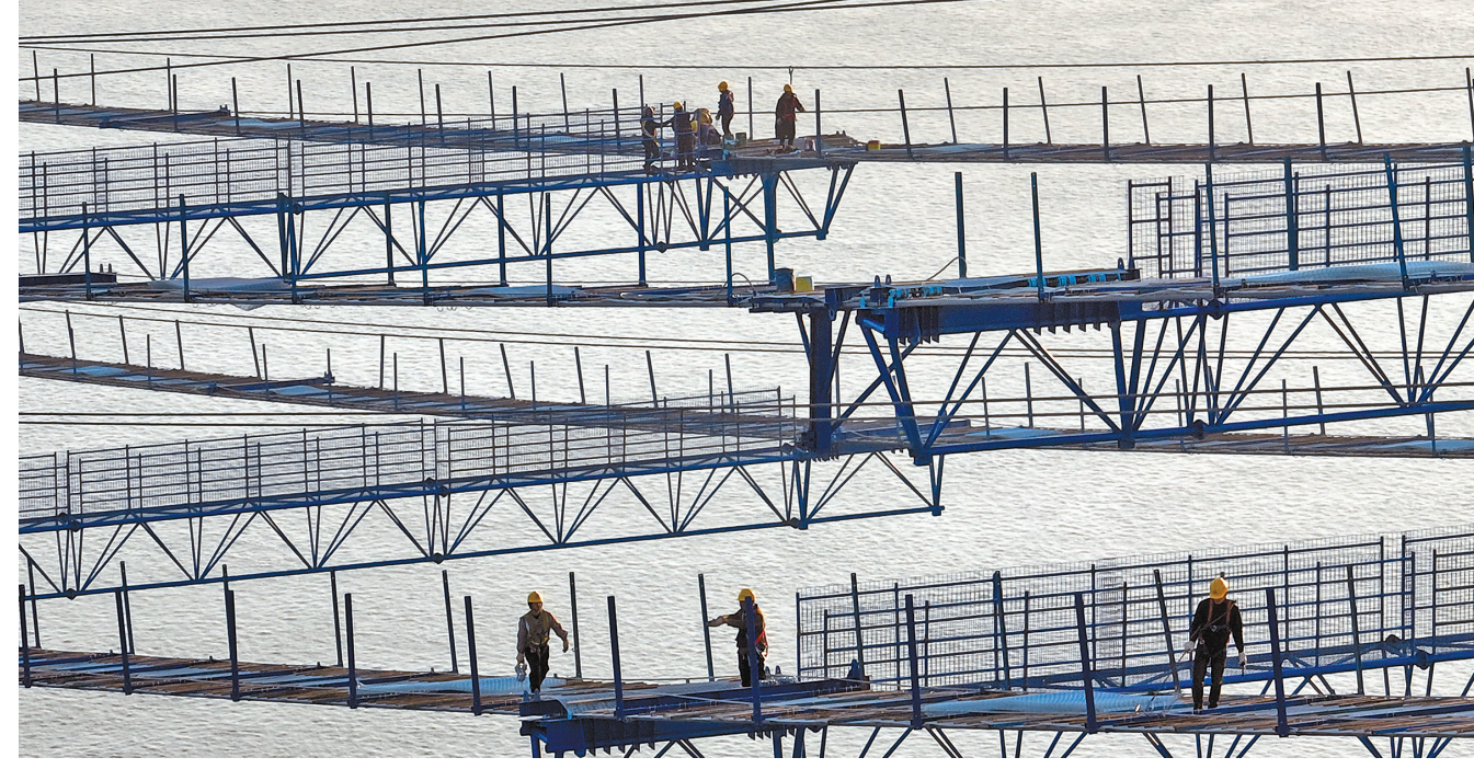
近日,在燕矶长江大桥的猫道面网铺设施工现场,建筑工人在距离江面近200米的高空作业,伴着脚下的长江波涛,稳步推进工程建设。
