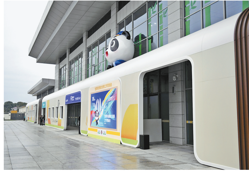
11月10日,国铁集团在成都展示我国首个旅游列车专属基地车站——安靖站。该车站距成都市中心10公里,共有3站6线,衔接宝成、达成、沪蓉、川青、成昆、成雅等多方向线路,可为直通普速旅游列车抵蓉后提供快捷接驳,方便旅客快捷赶往青城山、都江堰、黄龙、九寨沟等著名景点。
