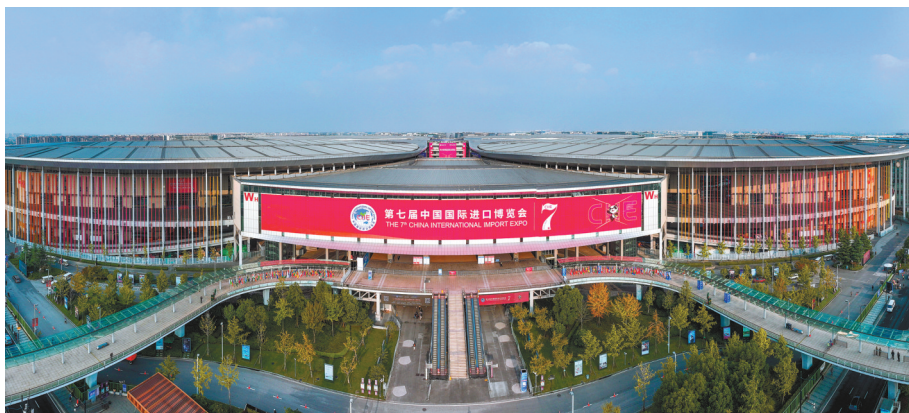
图为11月2日拍摄的国家会展中心(上海)西入口(无人机全景照片)。
