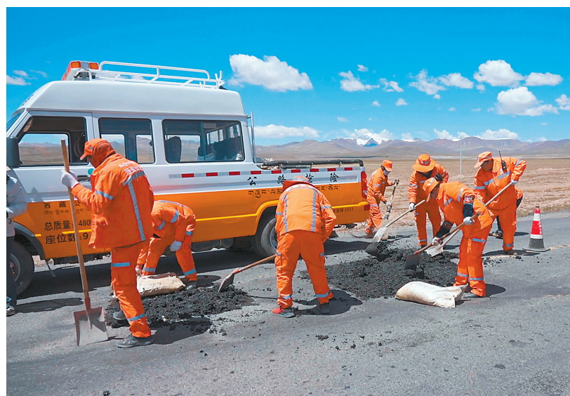
图为109养护保通点职工在修补路面。
