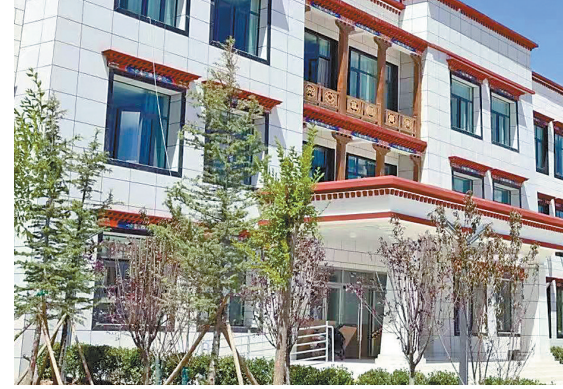
近日,由中交一公局集团有限公司承建的拉萨市城关区第十小学项目正式竣工。拉萨市城关区第十小学位于北绕城路以北、色拉路以西。总建筑面积约1.7万平方米,包括教学楼、综合楼、食堂、风雨操场以及相关附属工程。学校招生规模达36个班,可容纳学生约1620人。
