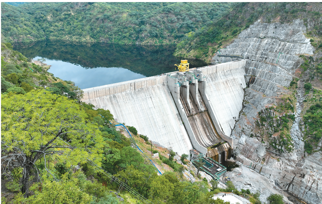
这是2023年3月23日在赞比亚南方省航拍的由中国电力建设集团有限公司承建的下凯富坎水电站大坝。
