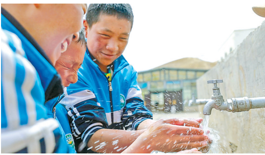
谢通门县县城自来水管网升级改造后，学生用自来水洗手。
