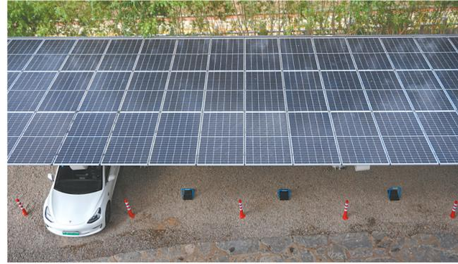
“光储充”一体化超级充电站是将阳光转化为电能,通过储能设备储存能量,使用储存能量给车辆充电,提高能源使用效率。这不仅可以降低出行成本,还能推动新能源产业的发展,起到保护生态环境的作用。
